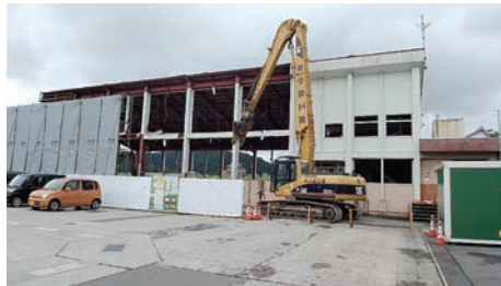
解体作業が始まりました
