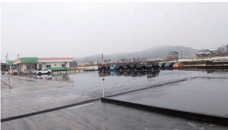
11月解体作業終了後整地されました
