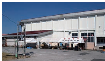
車庫取り壊し前
