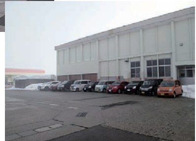
車庫取り壊し後
