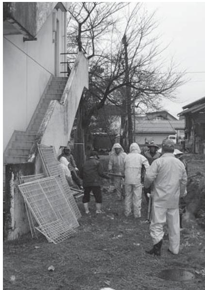
囲い作業の様子
