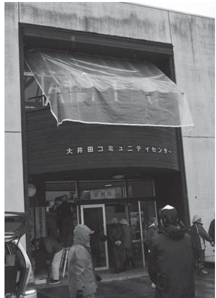
玄関屋上シートを新調しました
